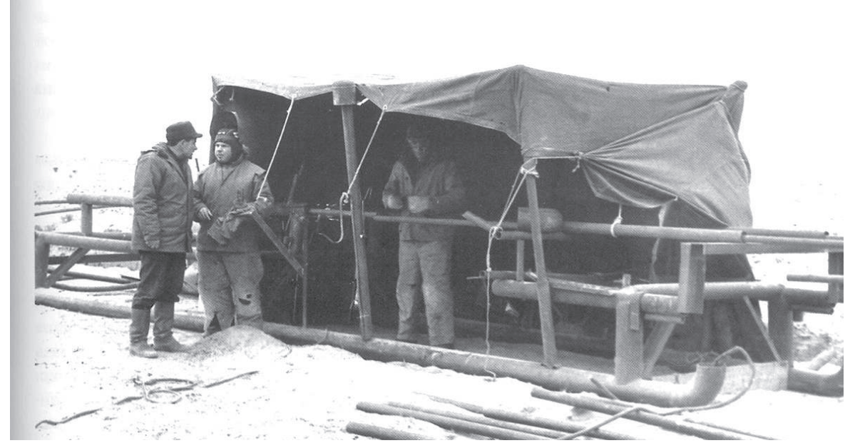
Строительство ПХГ «Бозой». Сварка шлефов.
